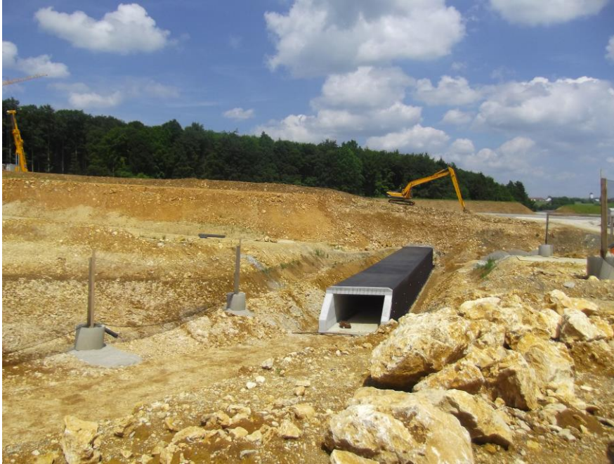
Abb. 2 Im Bau befindlicher Fledermausdurchlass unter der Bahnlinie
